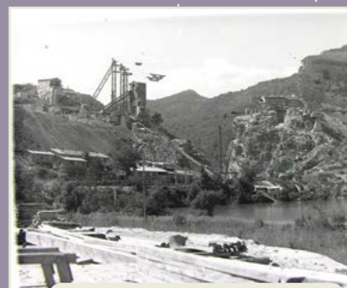
Début des travaux des barrages de Castillon et Chaudanne 1928
