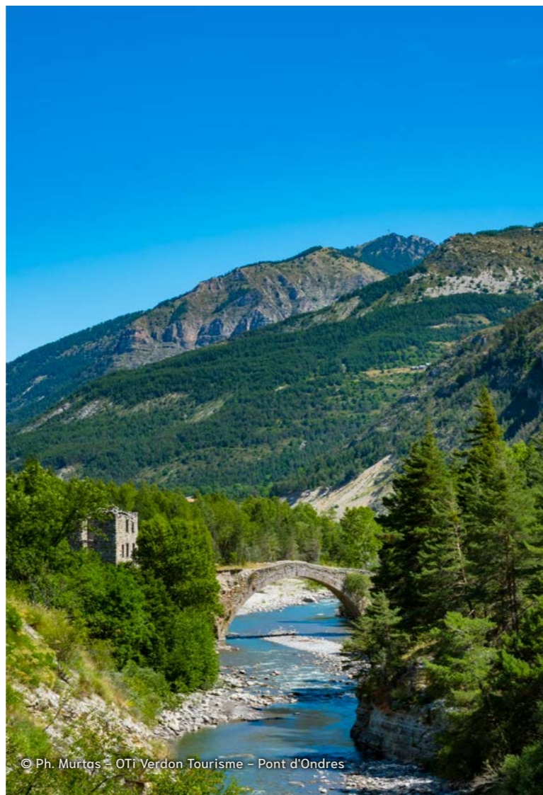
© CCAPV - Pont d'Ondres en travaux
