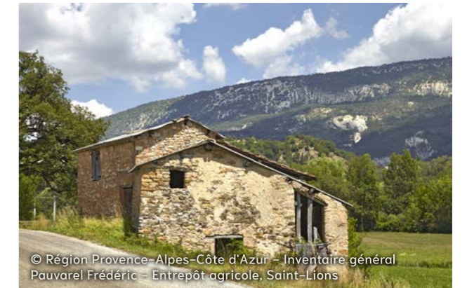
© Mathieu Simoulin - Verdon Pictures - Entrepôt agricole, Angles
